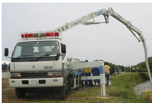
排水ポンプ車（鳥取市福部町）
