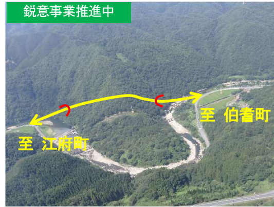
国道181号（佐川～根雨原工区）
