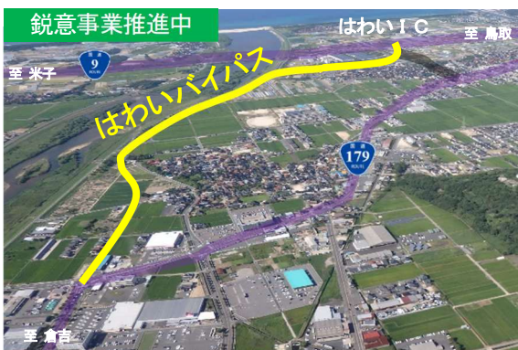
はわいバイパス（はわいIC付近）
