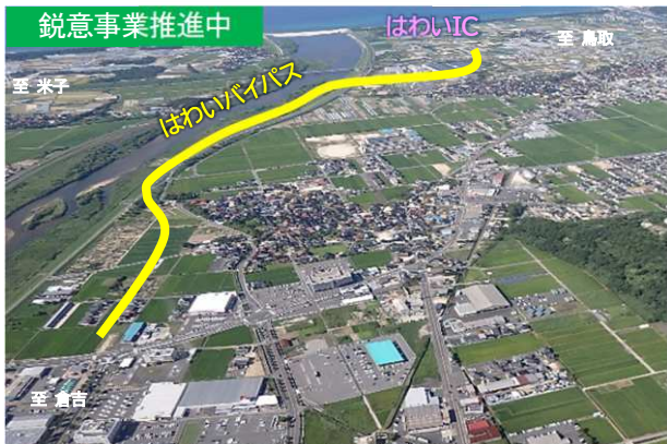
はわいバイパス（はわいIC付近）
