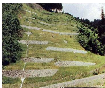
工事完成後（S40年代）
