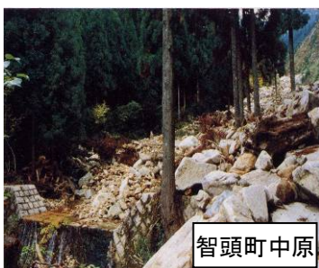
崩壊状況（S50年代）
