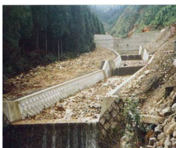
工事完成後（S50年代）
