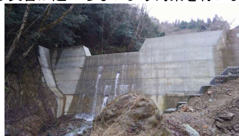
復旧完了（H31.2）
