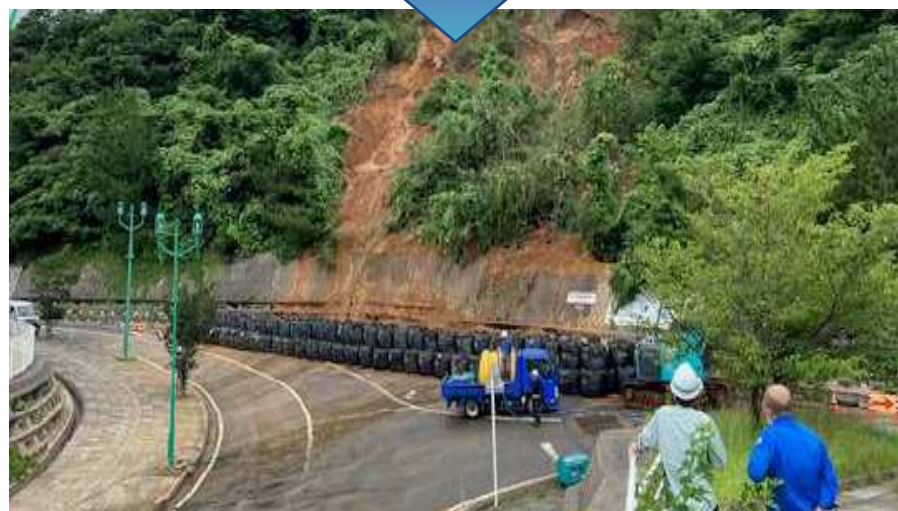
▲地方機関の土木技術者が現地に赴き概略調査を実施。直ちに、地元建設業者の協力を得て、路面の土砂撤去をするとともに、道路法面に不安定な土砂が残っていたため、落ちてくる土砂を補足するためのポケットを大型土のうにより設置。これにより片側通行規制に切り替え、迅速に地域交通を確保しました。
