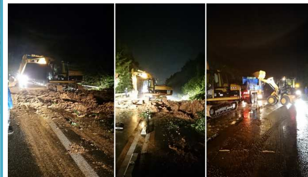
▲地元建設業者による災害時の緊急夜間工事
