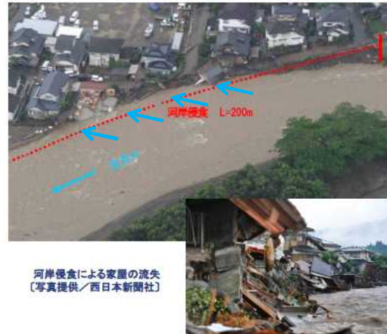
河岸侵食により家屋倒壊した状況
