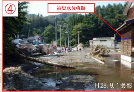
浸水解消後の流木等散乱状況
