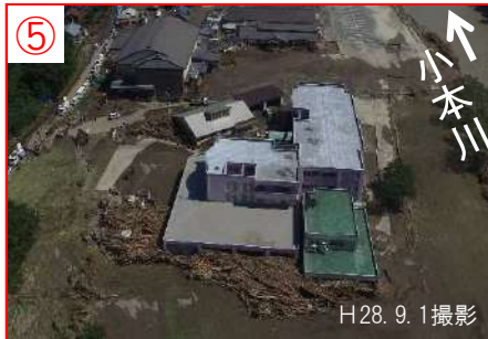
流木堆積状況
