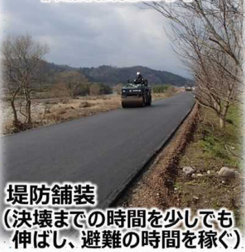
【堤防強化工事】
