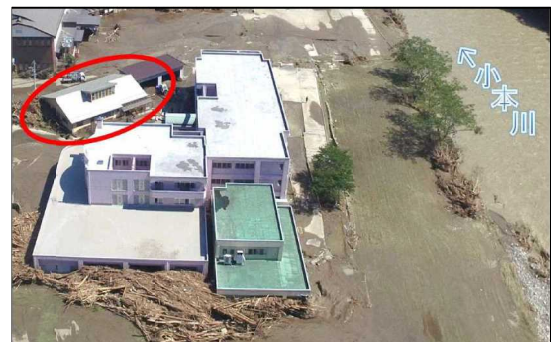
平成28年台風10号により、岩手県の要配慮者利用施設では利用者9名の全員が死亡。
