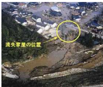
一堤防決壊に伴う氾濫流で木造家屋が倒壊した状況
