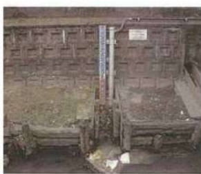
水位計設置状況
