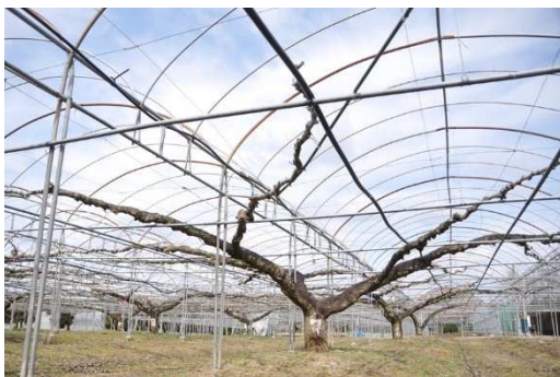
写真1 側枝切除直後の状況
