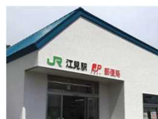
駅舎の 新改築・移設
