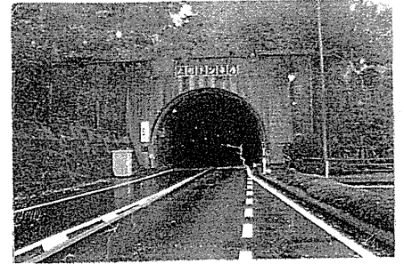
起点側坑口 (岡山側)
