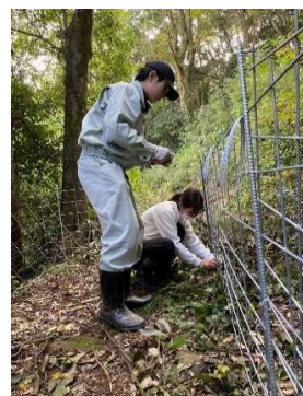
獣害対策の柵の設置
