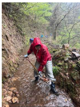
水路清掃の様子
