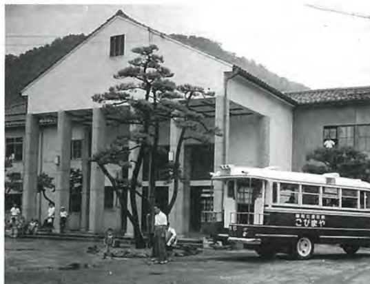
昭和19年建築の庁舎（3代目）
