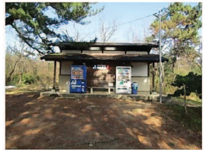
②トイレ（改修）
