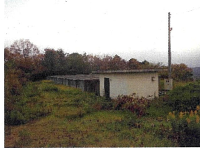
参考：果樹園地で共同利用される水道施設（五色ヶ丘果樹園地）
