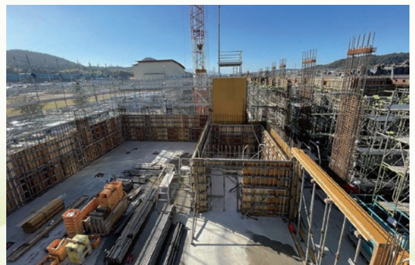
着々と工事が進む美術館。ウェブサイトでは「建設現場リポート」を発信中(写真は1月時点)
