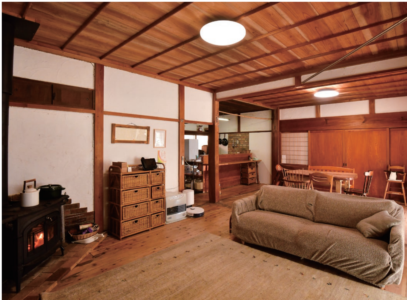
南向きの縁側から明るい陽光が差し込む、1階のリビングダイニング。改修前は2間続きの和室だった。地元製材所から規格外の智頭杉の板を格安で譲り受け、天井と床に張った。杉のいい香りと薪ストーブの暖かさに包まれる。
