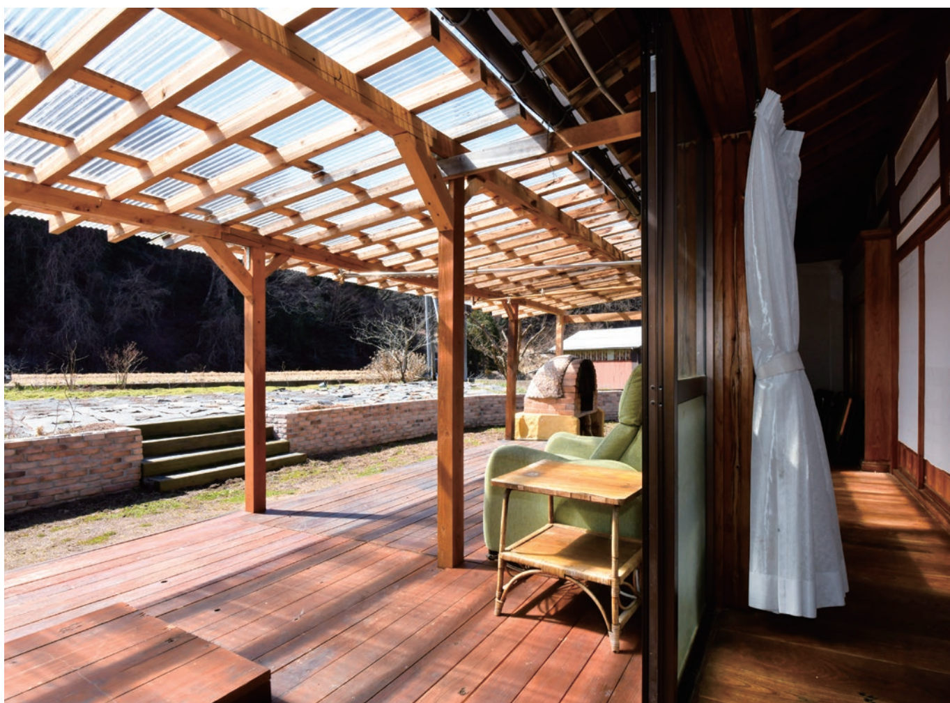
2回目の改修で造った屋根付きのベランダ。床板の一部を開けると砂場と囲炉裏が登場する。子どもたちの遊び場であり、友人らとBBQを楽しむ憩いの場でもある。
