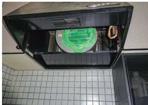
写真 4-17 台所レンジフードファンの目張り例
