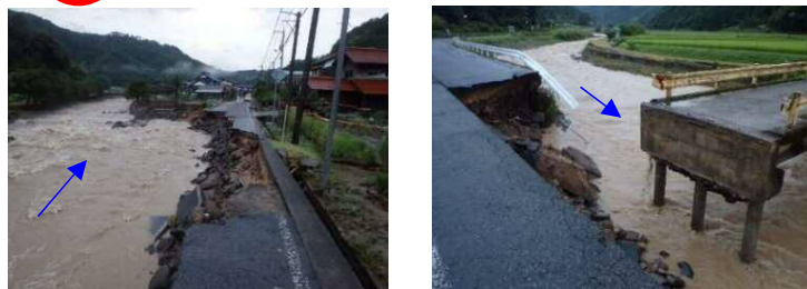
7 国道482号（鳥取市用瀬町別府～佐治町栃原）の道路崩落、土砂流出
