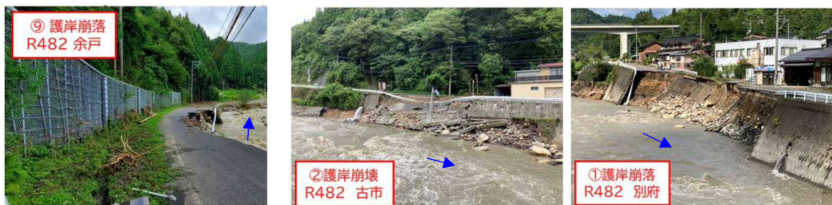
7 国道482号（鳥取市用瀬町別府～佐治町栃原）の道路崩落、土砂流出
