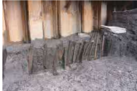
土留めに打ち込まれた杭列（P11区）
