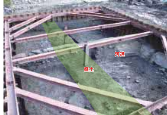
護岸のために築かれた盛土（P10区）
