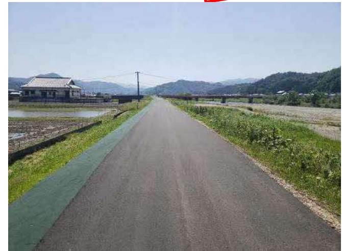
R4施工箇所：八東川（八頭町）
