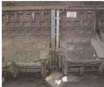
水位計設置状況
