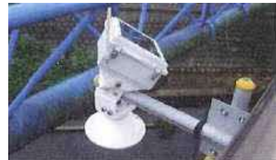
低コスト型水位計の設置例
