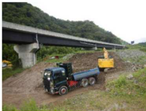
土のう用土砂積み込み状況 (国土交通省土砂ストックヤード)
