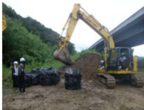
鳥取県による土のう製作状況
