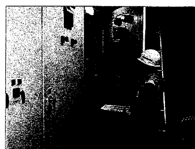
職員による電気設備の点検
