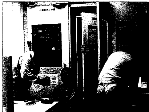
消防設備点検業務
