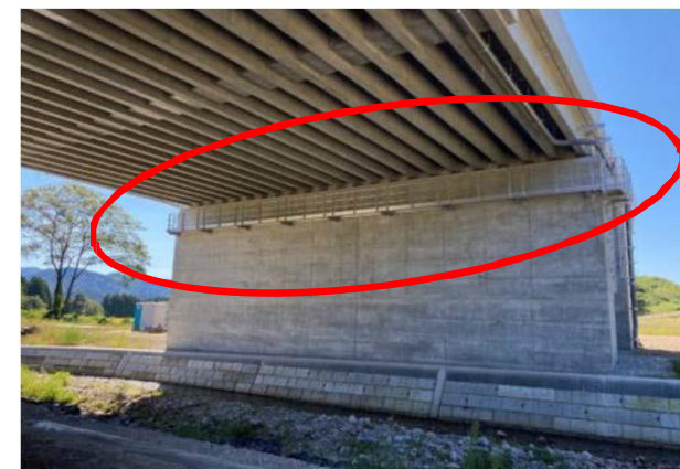
工種名：橋梁検査路架設工
