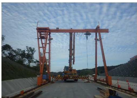
門型クレーン
