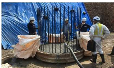
グラウト注入状況
