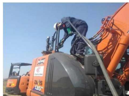
バックホウ給油状況
