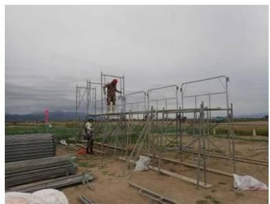
手摺先行型枠組足場
