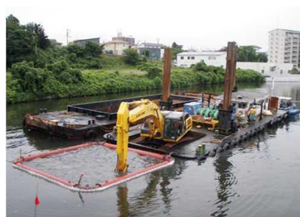
バックホウ浚渫船による浚渫作業
