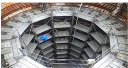
坑内足場設置状況
