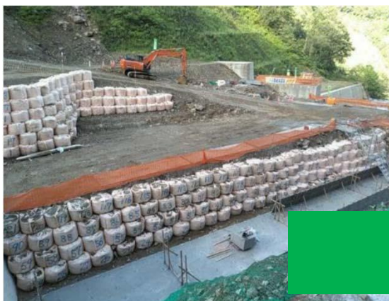
工種名：砂防土砂仮締切 ・砂防大型土のう仮締切
