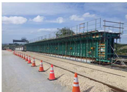
主桁製作用型枠 (鋼製型枠)
