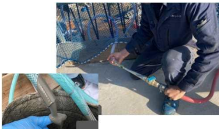
グラウト注入作業状況
