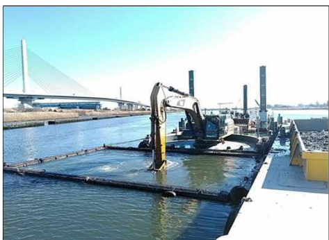
バックホウ浚渫船による浚渫作業
