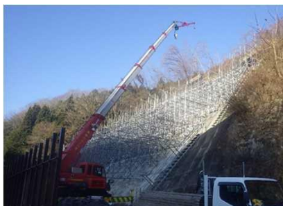
単管傾斜足場
