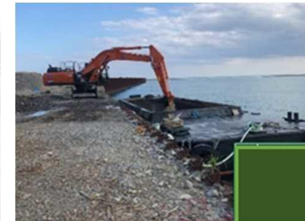
浚渫土の揚土作業
