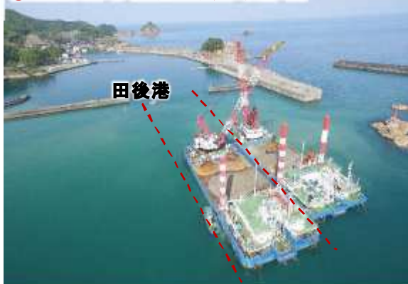
①航路浚渫(大型起重機船2隻体制)
