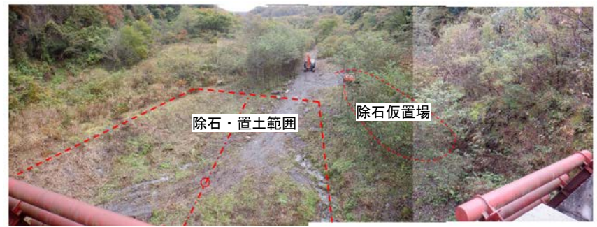
伐採後・掘削前
