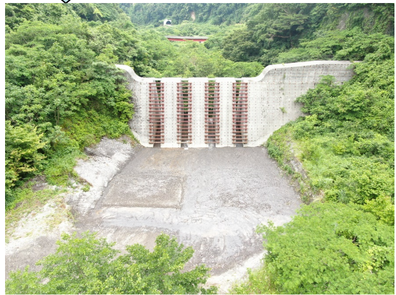
掘削+置き土の工事後(2023(令和5年).6)
