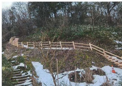
(完成した遊歩道の様子)
