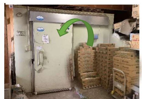
⑥冷蔵庫の設置
