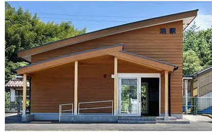
改修後のJR泊駅外観
