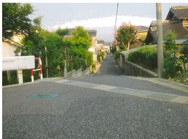
写真-2 旧左岸堤防と河道の高低差(秋里)
