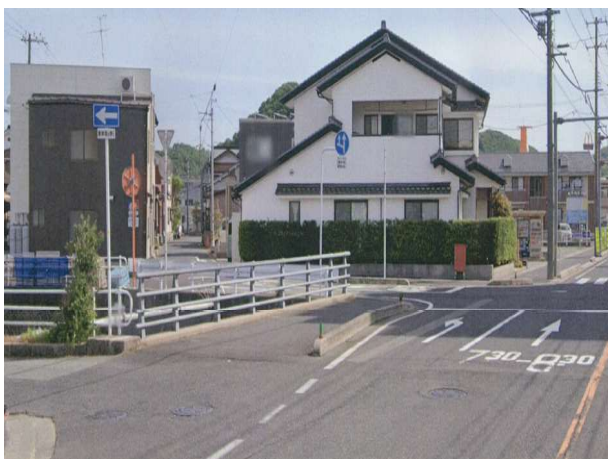
写真-3 旧右岸堤防の跡(松並町)
