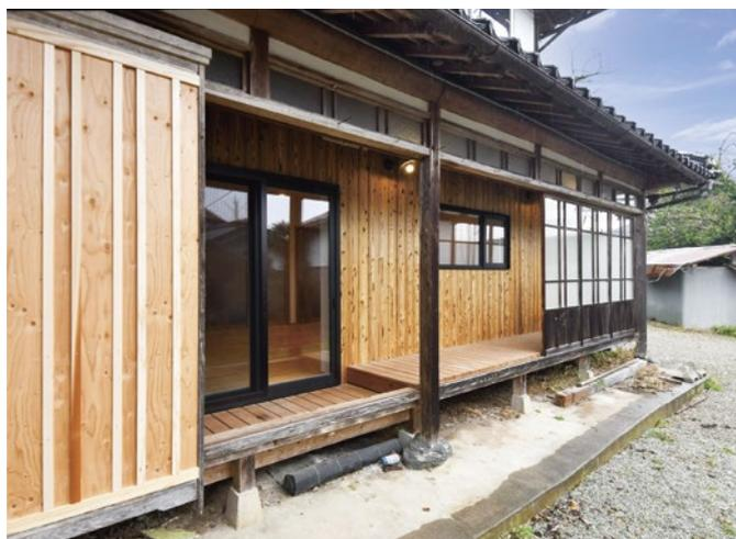
ウッドデッキに変わった縁側。もともと内壁だった位置には、耐震及び断熱を施した分厚い外壁を新設。雨戸はそのまま再利用、昔ながらの造りに懐かしさがこみ上げる。雨戸としてだけでなく夏の直射日光を防ぐ役割も担っており、おかげで室内は冷暖房した温度が長く保たれ、過ごしやすい。
