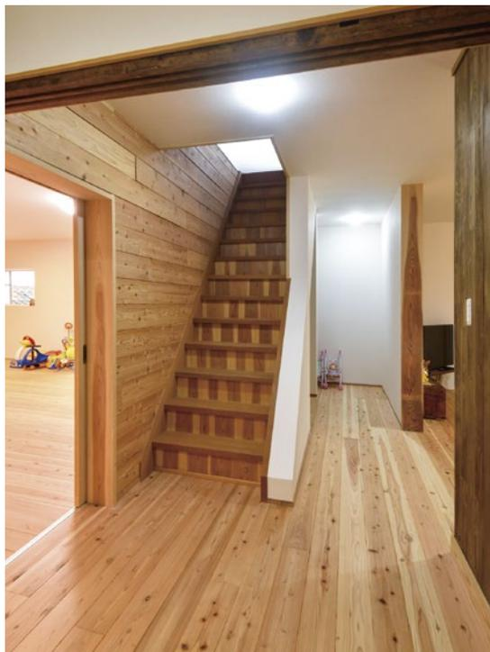
居住エリアの要所要所に耐力壁を入れて補強。同時に、冷暖房費を抑えられるよう断熱改修も行っており、省エネ化を実現している。階段から上の2階部分は未改修。
