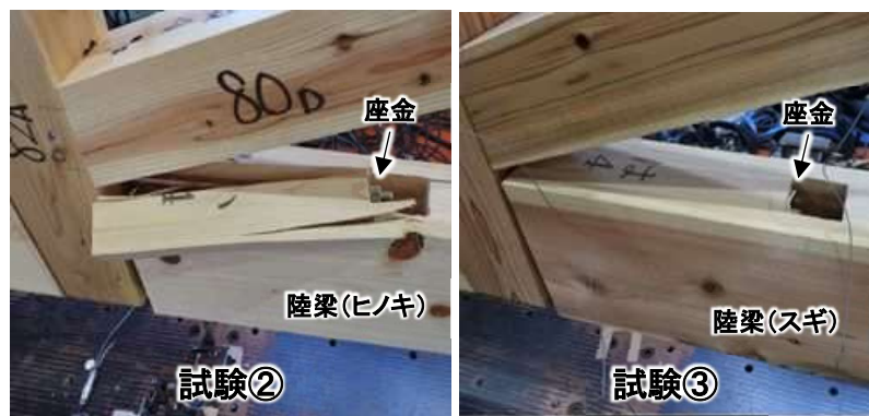
写真1 試験後の破壊状況(トラス中央部)
