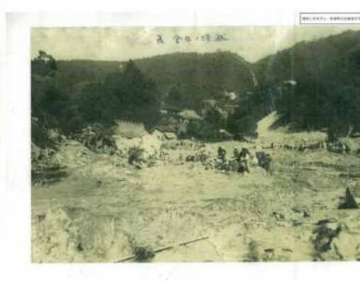
現 第1県営ダム・供養塔付近
