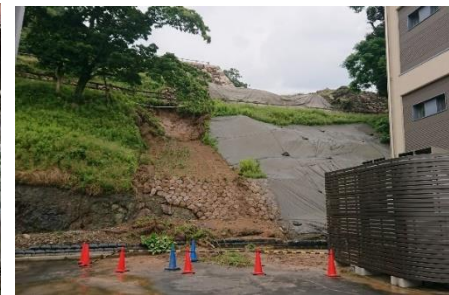
7/15 鳥取城の斜面崩落
