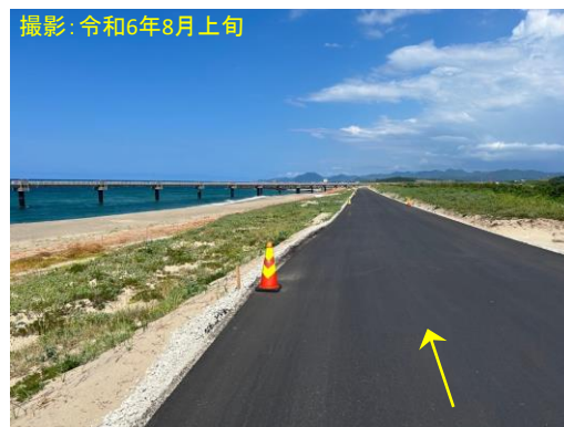
写真-1 工事用道路(国道9号からの進入路)
