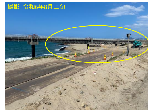
写真-2 拡張工事区域(埋め立て区域)
