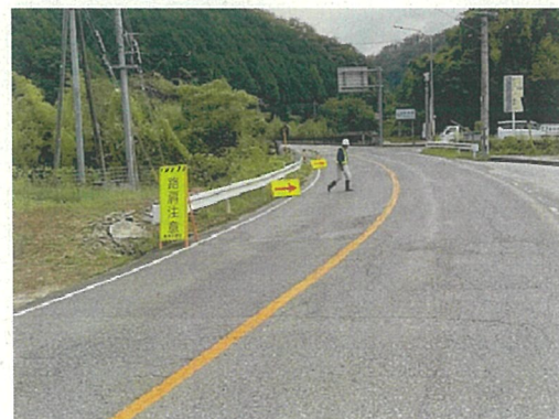
9/2 11:00 路肩規制状況
