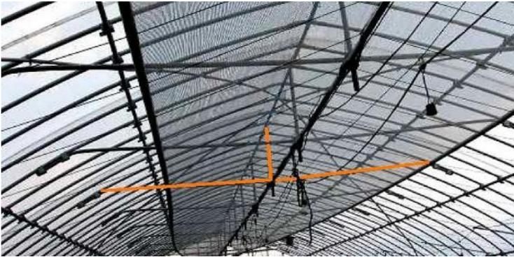
**写真1 タイバー設置の例**
