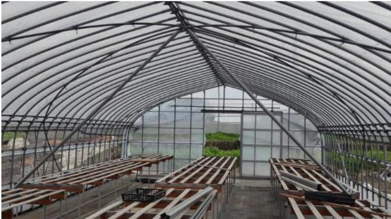
写真11 斜め支柱設置の例
