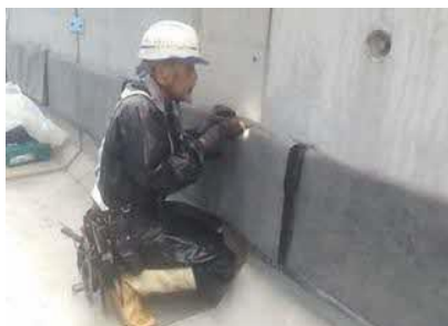
排水材設置工
