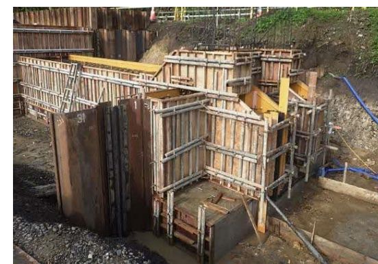
型枠工（省力化構造）
