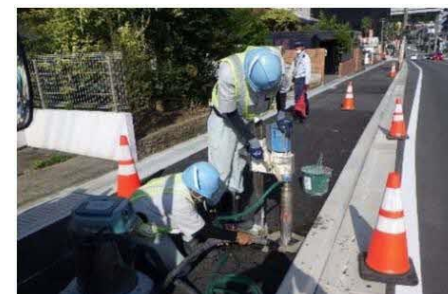
舗装版削孔工
