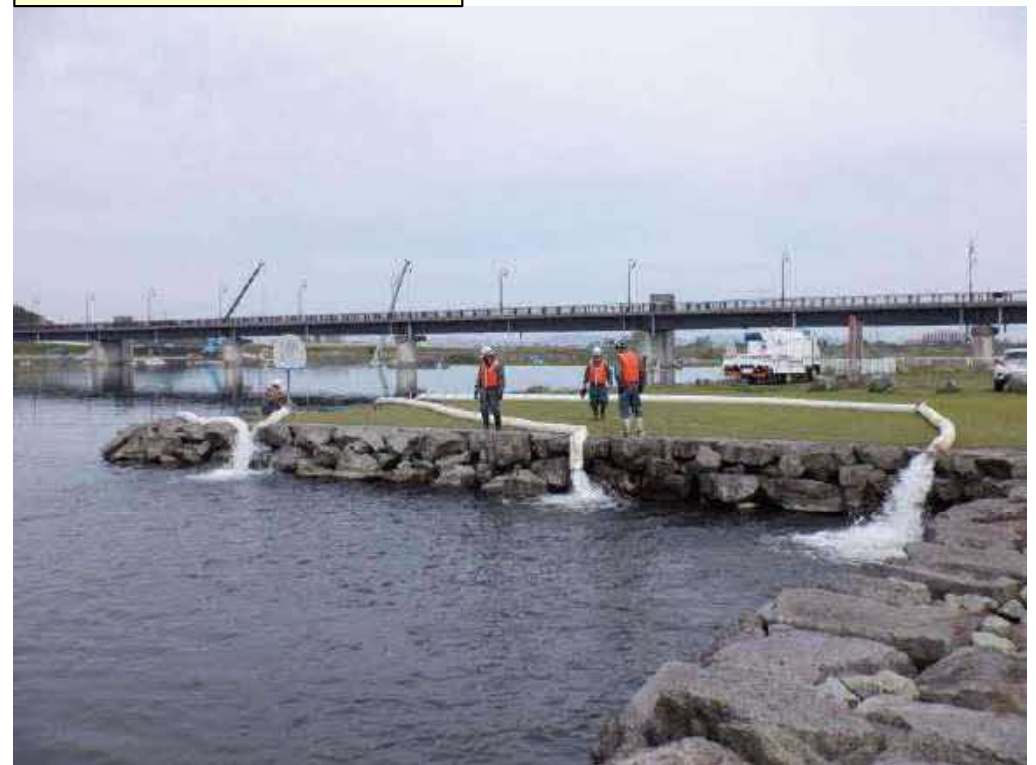
排水ポンプ車訓練(令和5年度)
