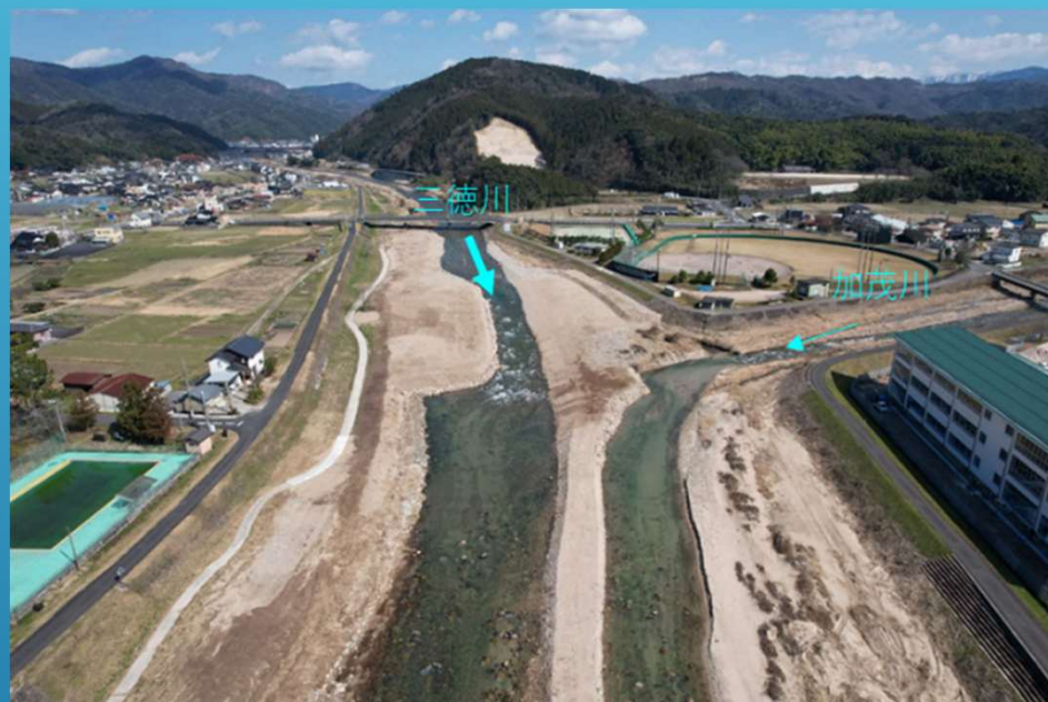
堆積土砂応急復旧後
