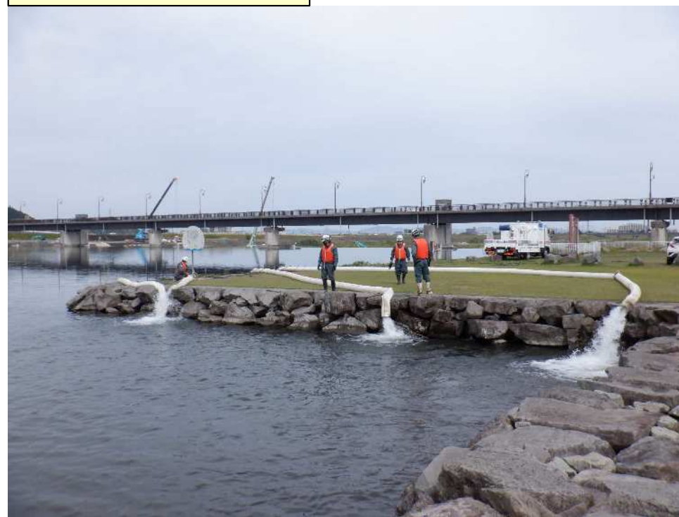
排水ポンプ車訓練(令和5年度)
