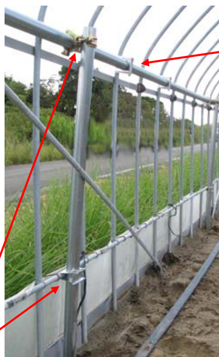
図22 単管パイプによる補強 (静岡県原図を一部改変)
