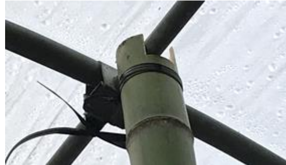
図14 中柱先端の加工と固定
