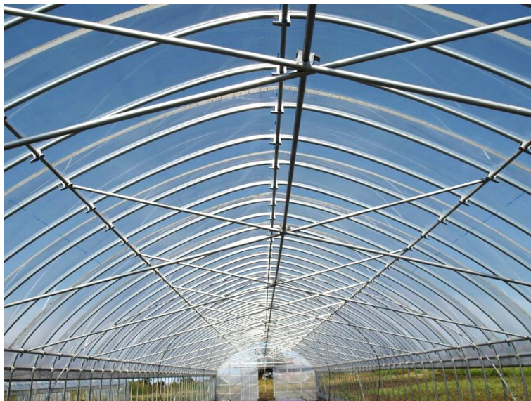
図8 Xタイバーによる補強の事例
