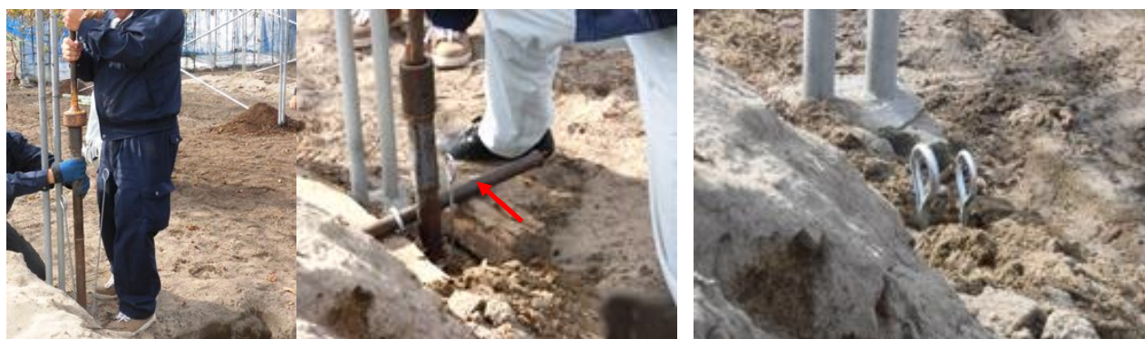
図31 補強に用いるアンカー
