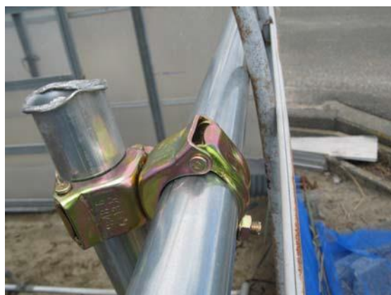
図21 自在クランプによる単管パイプの固定 (静岡県原図)
