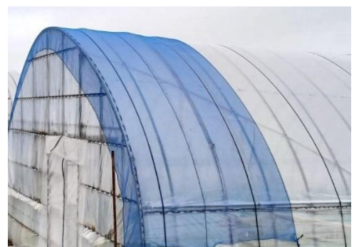
図26 妻面の防風ネットによる補強
