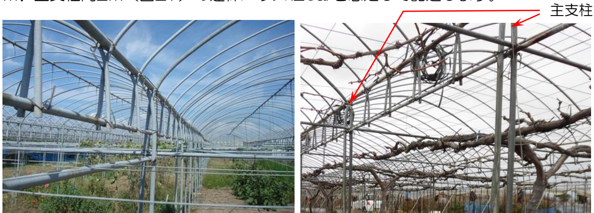
図27 現在主流のブドウ連棟ハウス
