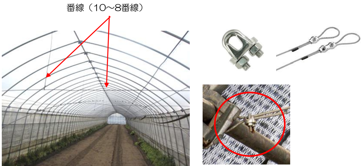
図16 水平引っ張り線による補強の例と番線を留めるワイヤークリップ (群馬県原図を一部改変)
