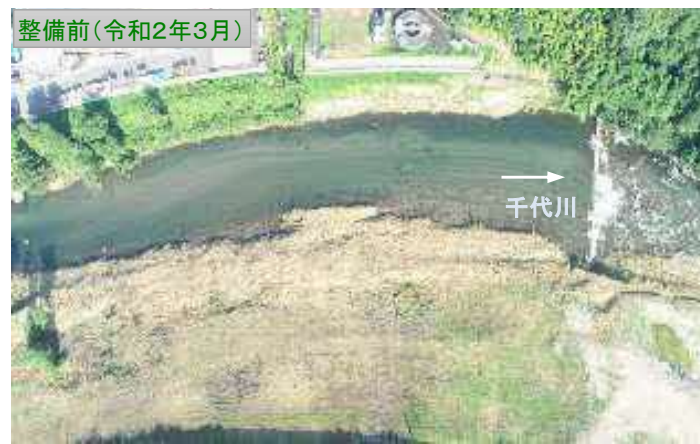
用瀬町美成地区 整備状況(23k200付近)
