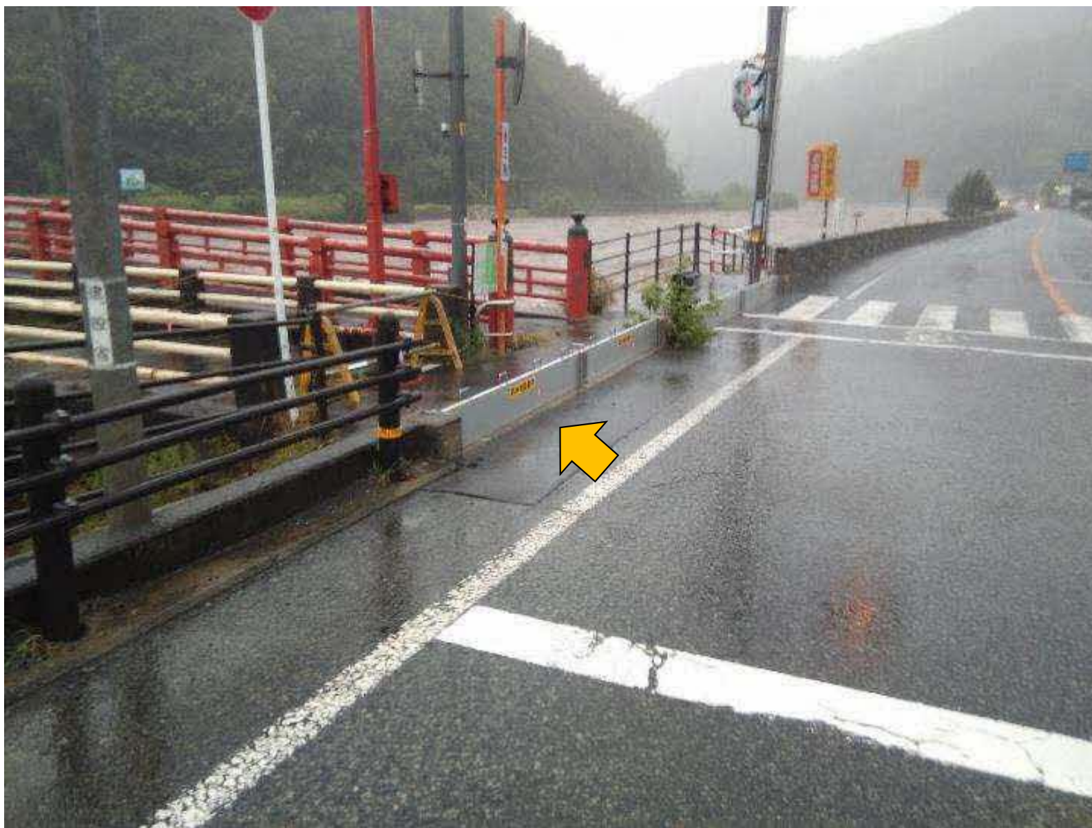
用瀬陸閘門設置状況
