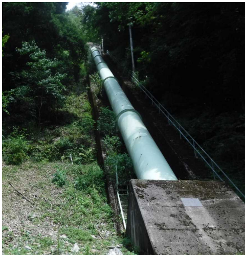
<水圧鉄管の外観>
