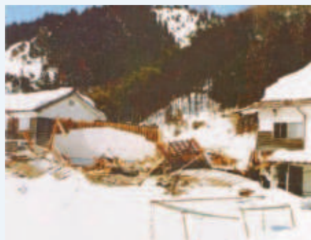
雪の重みで全壊した成器小学校体育館 (鳥取市国府町)
