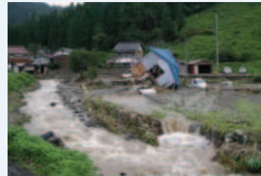
若桜町寺所(角谷川)の被災状況
