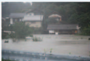
米子市青木(小松谷川)の冠水状況
