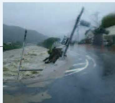
国道 373 号 (智頭町南方) の被災状況
