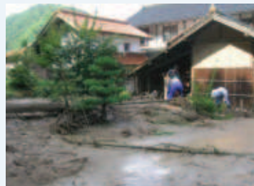
琴浦町上中村の被災状況
