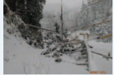
電柱倒壊の状況 (八頭町姫路)
