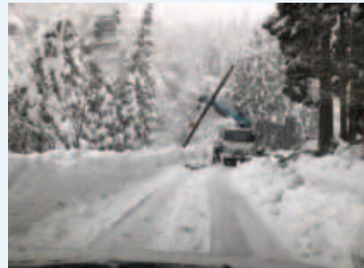
復旧作業の状況 (若桜町来見野)
