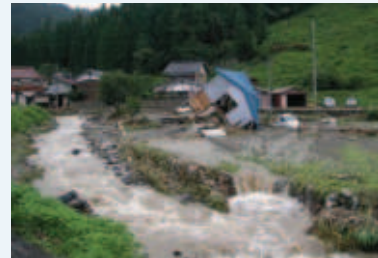
若桜町寺所(角谷川)の被災状況
