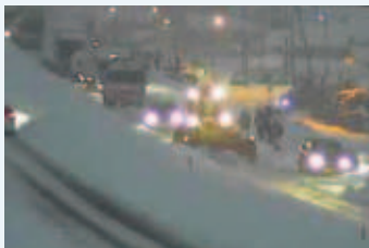
国道 9 号における除雪状況
