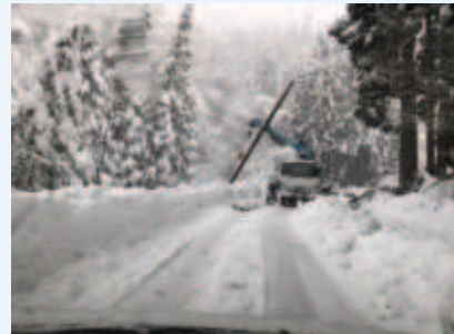
復旧作業の状況 (若桜町来見野)
