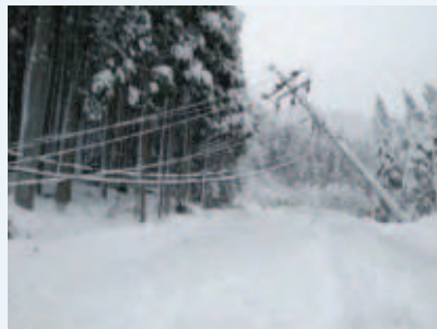
電柱倒壊の状況 (若桜町来見野)
