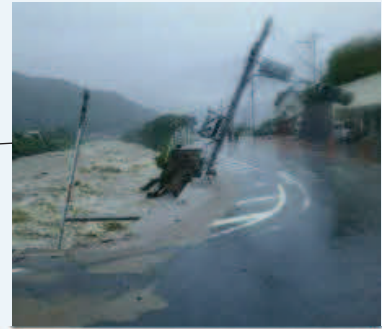
国道 373 号 (智頭町南方) の被災状況
