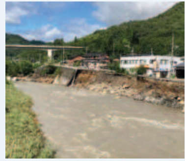
国道 482 号 (鳥取市用瀬町別府) の被災状況
