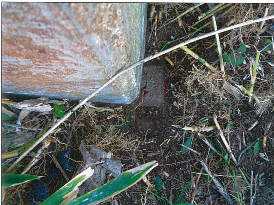
No. 3 標識: コンクリート杭 既存
